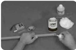
3. Aplique una cantidad suficiente de cemento en el extremo del tubo (equivalente al largo interno de la conexión a insertar) y luego al interior de la conexión empleando el aplicador proporcionado dentro del envase o con una aplicador adecuado. En tubos tipo campana no permita que el producto sobrepase el tope interno, para así evitar la acumulación de manera uniforme sobre la pieza.
