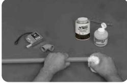
2. "Limpie las superficies tanto de la tubería como el interior de la campana de la conexión, eliminando impurezas y de esta manera preparar las superficies."
