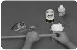
1. "Corte la tubería a escuadra (90°) y limpie la superficie evitando la presencia de rastros de rebaba que surgen al hacer el corte. Observe que el encaje entre la tubería y la conexión genere fricción entre las superficies de contacto."
