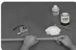
4. Rápidamente una la tubería con la conexión con un movimiento ligeramente rotativo. Girar ¼ de vuelta. Aplique la presión suficiente para asegurarse que el tubo ingrese hasta el tope de la conexión. Mantenga la presión de 10 a 20 segundos para asegurarse que el tubo no retroceda, luego retire el exceso de producto. Evite mover el área soldada.
