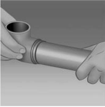
**7.** Inmediatamente proceda a la unión. Pare la introducción del tubo en la conexión cuando los dos anillos visibles que se forman en función del movimiento del material estuvieran unidos.
