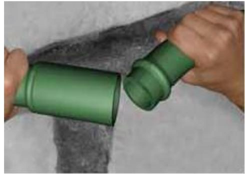
**3.** Inmediatamente proceda a la unión, retirando los calces para que la tubería, vuelva a su posición normal.
