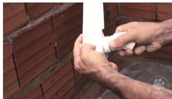
**7º Paso:** Siga la instalación hasta la caja sifonada. Recuerde que el Ralo Lineal Tigre, es seco, no sifonado.
