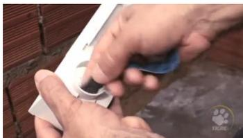
**6º Paso:** Realice la instalación normalmente primero, lijando ambas partes, luego solución preparadora y por ultimo el Adhesivo, siempre en ambas partes a soldar.
