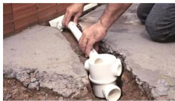
**8º Paso:** No incline el Ralo Lineal Tigre, pues ya tiene su desnivel necesario incorporado basta darle al tubo, el desnivel necesario hasta la caja sifonada Tigre.
