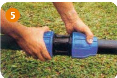
**Paso 5:** Ajuste manualmente las roscas de las extremidades.
