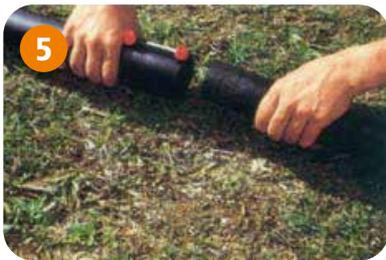
**Paso 5:** Retire la conexión del embalaje, tomando la precaución de no tocar la región interna de la pieza donde se ubica la resistencia eléctrica. Encaje la unión, observando la marcación efectuada, que indicará la profundidad de la bolsa hasta donde debe llegar la inserción de la conexión.
