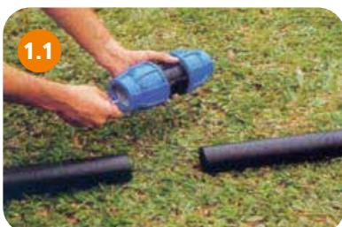
**Paso 1.1:** Con la rosca de las extremidades apretadas, mida la profundidad de la campana de conexión.
