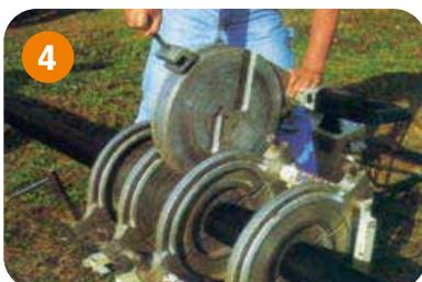
**Paso 4:** Usar la cuchilla de corte para rectificar las superficies a ser unidas.
