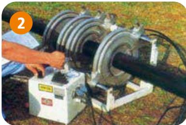
**Paso 2:** A partir de la tabla entregada por el fabricante, verifique la presión de soldadura requerida y súmela a la presión inicial para desplazamiento (inercia de la máquina más el peso propio del tubo a ser desplazado).
