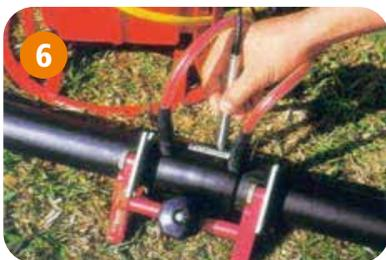
**Paso 6:** Instale el alineador, conecte los cables de la máquina a los bornes de la conexión y pase el lector óptico sobre el código de barra. Ejecute la soldadura y aguarde el tiempo de enfriamiento recomendado por el fabricante. No retire el alineador durante el tiempo de enfriamiento y evite mover el conjunto durante este proceso.
