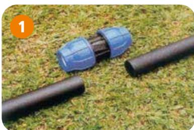
**Paso 1:** Con la rosca de las extremidades apretadas, mida la profundidad de la campana de conexión.
