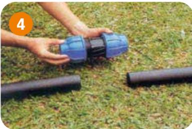
**Paso 4:** Encaje el tubo en la bolsa de conexión.
