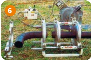
**Paso 6:** Formado el cordón, retire la presión de soldadura y mantenga la placa en contacto con los tubos por el tiempo recomendado por el fabricante del equipamiento.
