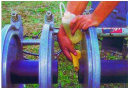
**Paso 4.** Limpiar la superficie con la solución a base de alcohol y a partir de ese instante evite tocar la región a ser soldada.
