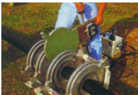
**Paso 6.** Retire la placa calentadora y aproxime los tubos. El cordón de soldadura aumentará de dimensión. Espere el enfriamiento recomendado por el fabricante del equipo.
