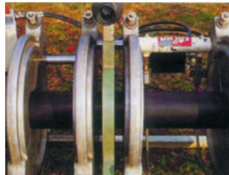
**Paso 5.** Cuando la temperatura de la placa calentadora llegue al valor recomendado por el fabricante, posiciónela manteniendo la presión de soldadura hasta la formación de un cordón inicial entre la placa y el tubo (la tabla suministrada de la máquina indicará la dimensión del cordón).
