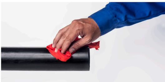
**Paso 1.** Limpie muy bien y seque el extremo de la tubería.
