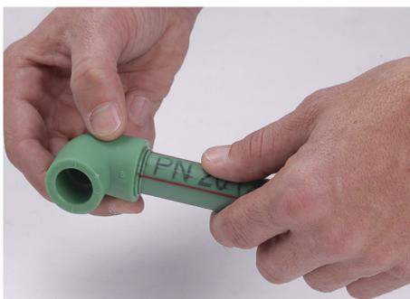
9. Detenga la introducción del caño en el accesorio cuando los dos anillos visibles que se forman por el corrimiento del material se hayan unido.
