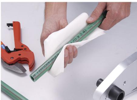
3. La limpieza del tubo antes de introducirlo en las boquillas garantiza la duración de las mismas.
