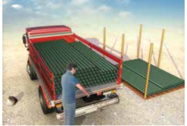
Descargar los tubos con cuidado.
