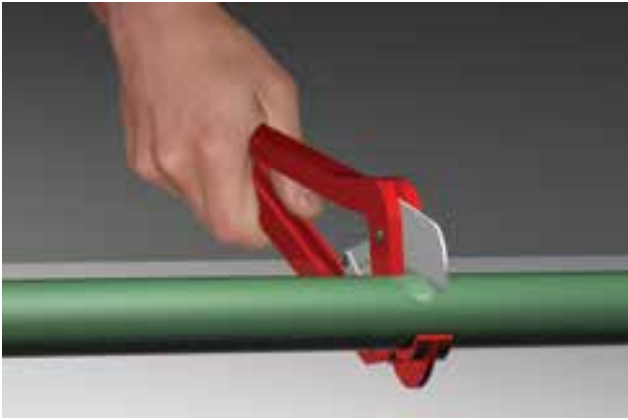
Cortar los tubos con herramientas Fusión Tigre afiladas. Así se obtendrán cortes rectos, sin ovalación ni rebabas.
