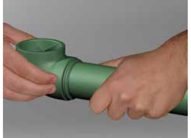
Las correcciones deberán limitarse a 15° de giro y se realizarán durante el tiempo de manipulación de la unión.
