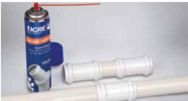
3. Se deslizarán las cuplas hasta cubrir las uniones entre el tubo nuevo y los extremos del original. Para facilitar el proceso, se deberá colocar solución lubricante.
