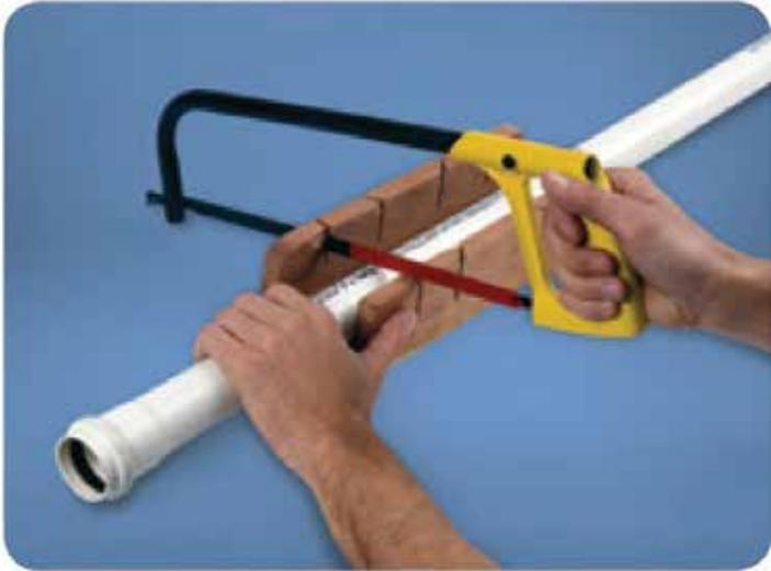
1. Cuando resulte necesario, cortar los tubos con una sierra de dentado fino. La utilización de una caja de corte permite realizar un corte perpendicular.
