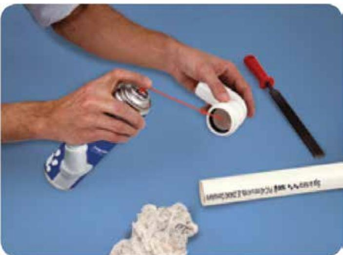
3. Limpiar la junta de estanqueidad, el interior del abocardado y el extremo macho. Aplicar solución o pasta lubricante sobre el O'Ring.
