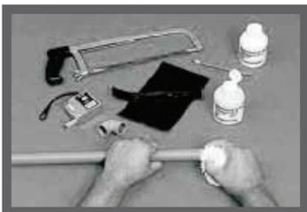
**Paso 3:** Distribuya uniformemente el Adhesivo Plástico para PVC Tigre en las campanas y espigas que se soldarán (con el aplicador o con la punta del propio pomo)
