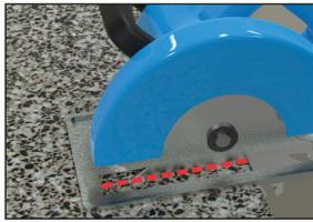
**Paso 1.1:** Realice el test previo de las piezas de la canaleta y el piso recortado del revestimiento (piso y portapiso), antes de la ejecución de la colocación. Eso evitará errores de asentamiento de las piezas y garantizará el nivel correcto; y, principalmente, la cantidad de masa/silicona que se utilizará para el perfecto encaje entre las piezas.
