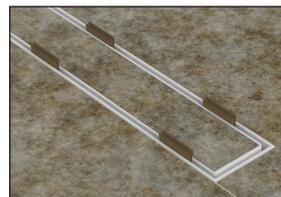
**Paso 4:** Realice el acabado con el piso deseado respetando la altura máxima del Perfil.
