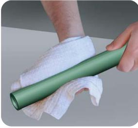
**Paso 3:** Limpie el extremo del tubo y el interior de la boquilla de la conexión a unir. Puede usar un trapo empapado de alcohol isopropílico.
