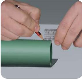
**Paso 4:** Marque la **profundidad de inserción** en el extremo del tubo de acuerdo al diámetro de la tubería (según la **tabla N°2**)
