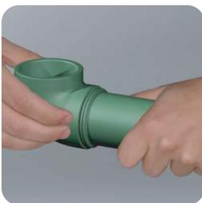
**Paso 7:** Inmediatamente proceda a la unión. Pare la introducción del tubo en la conexión cuando los dos anillos visibles que se forman en función del movimiento del material estuvieran unidos. Mantenga la unión con una ligera presión durante el **tiempo de fusión** según lo especificado en la **Tabla N°01**.
