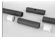
b) Cambie el trecho roto con otro segmento de tubo nuevo, con las mismas dimensiones que fue retirado;
