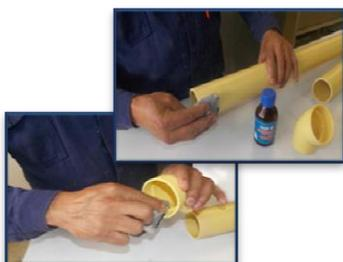
f) Aplique un poco de Limpiador en un paño limpio y seco, luego frote las superficies a unir tanto de la tubería como de la campana (parte interna) de la conexión, ES de vital importancia este paso ya que dentro de las funciones del limpiador no solo está la de limpiar las superficies, si no la de preparar las superficies para que la unión y hermeticidad sea eficientes
