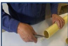
d) Elimine los excesos de viruta de PVC que se genera por el corte, ya que estas pueden afectar la unión entre el tubo y la conexión y generar goteos
