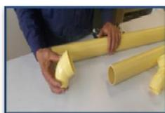
**a)** Inicialmente se debe realizar una inspección de que tanto la Tubería como las Conexiones se encuentran en perfecto estado sin evidencia de golpes y/o fisuras.
