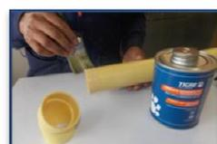
g) Proceda a realizar la aplicación del Cemento Solvente (previamente agite el recipiente con el fin de que se mezcle el contenido), utilice una brocha, aplique una capa proporcional sobre superficie externa de la tubería y sobre la parte interna de la campana de la conexión. (Es importante no generar excesos de Cemento Solvente en la aplicación ya que estos provocaran fugas por debilitamiento de las paredes tanto de la tubería como del accesorio).
