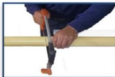
c) Corte el tubo a la longitud deseada y asegúrese que dicho corte quede a escuadra (90°), con el fin de que este conserve su longitud en cualquiera de los lados y hacer más eficiente la unión con la conexión
