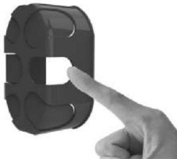
f) **Encaixar a caixa elétrica** – Depois de raspar os cantos remanescentes e quebrar as entradas necessárias, deve-se encaixar a caixa elétrica na abertura realizada na placa.
