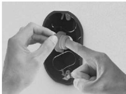
l) **Fixar a tomada/interruptor** – Posteriormente à fixação da caixa, dos olhais e da ligação dos fios elétricos, deve-se parafusar a tomada ou o interruptor nos olhais e, na seqüência, também o espelho.
