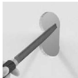
**d) Quebrar pastilhas** – Antes de colocar a caixa elétrica na abertura da placa, deve-se quebrar o número necessário de entradas para os eletrodutos. Com auxílio de um canivete, corte a junção da entrada.
