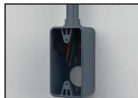
**Passo 2:** Parafuse os cabos de energia (fase, neutro e terra) nos pontos de contato da tomada a ser instalada.
