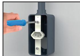
**Passo 4:** Parafuse a Tampa de 1 interruptor Hexagonal e conclua a instalação.
