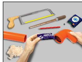
**Passo 6:** Introduza a ponta do tubo/conexão, até o final e depois recue a ponta para que montagem ocorra na região de Junta Elástica da bolsa, o que minimiza ainda mais as vibrações ao longo da instalação para a linha hidráulica.
