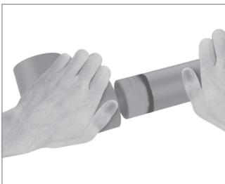
**Passo 10:** Encaixe de uma vez as extremidades a serem soldadas enquanto o adesivo estiver úmido, girando a 1/4 de volta e mantenha a junta sobre pressão manual por aproximadamente 30 segundos, até que o adesivo adquira resistência;
