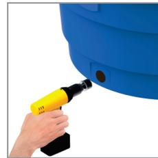
**Passo 1:** Fure a caixa d'água de acordo com a bitola do adaptador. Utilize uma serra copo.
