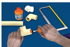
a) Com auxílio do pincel aplicador, proceda a distribuição uniforme do Adesivo Aquatherm® ou Adesivo Especial Tigre na bolsa da conexão e em seguida na ponta do tubo;
