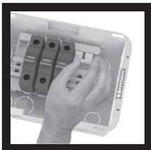
4- Faça a isolamento dos pinos não usados utilizando o isolador.
