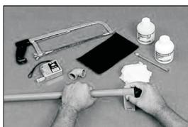
**Passo 1:** Lixe as superfícies a serem soldadas utilizando lixa 100. Teste o encaixe entre as peças, que deve ser bastante justo, quase impossível sem o adesivo, pois sem pressão não se estabelece a soldagem.
