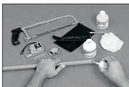
**Passo 3:** Distribua uniformemente o Adesivo Plástico para PVC TIGRE nas bolsas e nas pontas a serem soldadas (com pincel ou com o bico da própria bisnaga).
