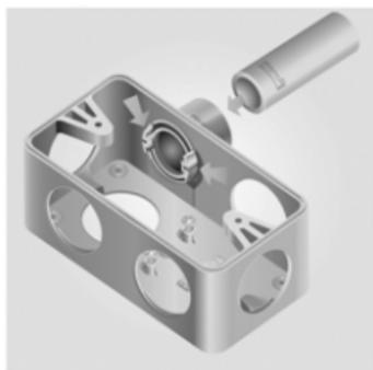
**Passo 6:** Após a inserção dos fios, instale as tomadas e interruptores e finalize com a instalação dos espelhos.
