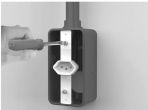
4) Parafuse a Tampa de 1 interruptor Hexagonal e conclua a instalação.
