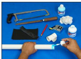
**Passo 4:** Encaixe de uma vez as extremidades a serem soldadas, promovendo um leve movimento de rotação entre as peças (Va de volta) até que atinjam a posição definitiva. Remova o excesso de adesivo.
