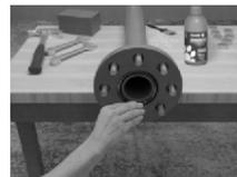
4) Coloque a junta de vedação plana na posição;
