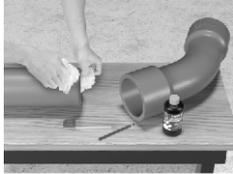
1) Limpar as superfícies da bolsa da conexão e da ponta do tubo utilizando estopa branca;
