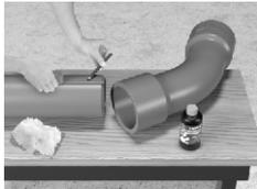
2) Medir a profundidade da bolsa da conexão e marcar na ponta do tubo;
