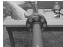
6) O aperto dos parafusos deverá ser gradual, procurando-se fixar sempre aquele diametralmente oposto ao fixado.
