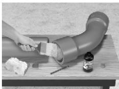
3) Aplicar o adesivo Tigre primeiro na bolsa e depois na ponta do tubo e, imediatamente, proceder à montagem da junta;
