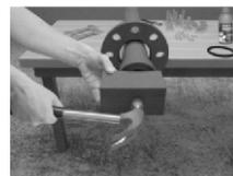
3) Com o auxílio de uma peça de madeira e usando um martelo, introduza o bocal do flange no tubo até atingir seu encosto;
