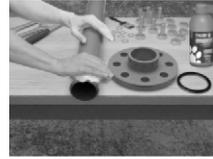
1) Limpe a ponta do tubo e a bolsa do flange com uma estopa branca;
